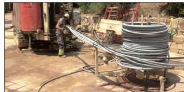
Introducción de sondas PE-XA en perforación geotérmica.
